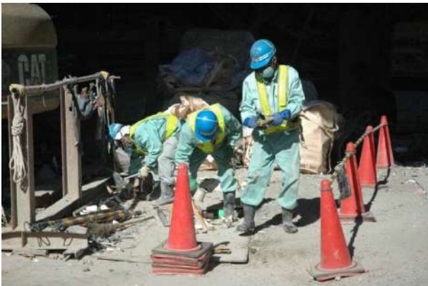
事故防止のため重機と人の動線を区画するパイロンとバーの設置、RL2マスク装着
